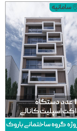
۱۲ عدد دستگاه داکت اسپلیت کانال پروژه گروه ساختمانی باروک
